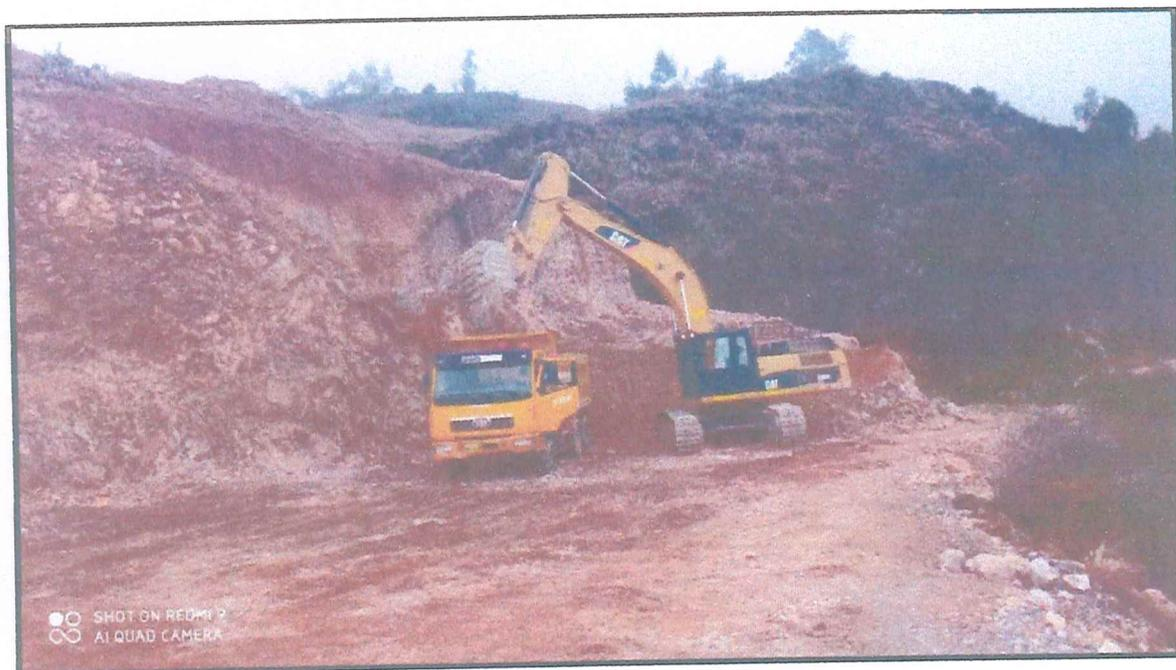
**FOTO N°04:** CARGUIO DE MATERIAL AFIRMADO PARA LA EJECUCION DE LOS TRABAJOS EN E CAMINO EMP. PE-1NF - DV. CA-1408 (SHAMON) - CASCABAMBA - EMP. CA-1404 (TAMBILLO)" L= 15.670 km
