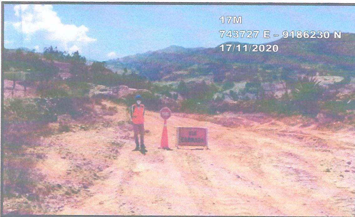
FOTOGRAFIA N°08: Señalización y control de tránsito en las áreas de trabajo
