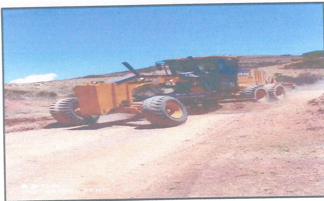
FOTO N°07 Y 08: VISTA DE TRABAJOS DE EXTENDIDO DEL MATERIAL AFIRMADO CON MOTONIVELADORA EN LA EJECUCION DE LOS TRABAJOS EN EL CAMINO EMP. PE-1NF - DV. CA-1408 (SHAMON) - CASCABAMBA - EMP. CA-1404 (TAMBILLO)" L= 15.670 km
