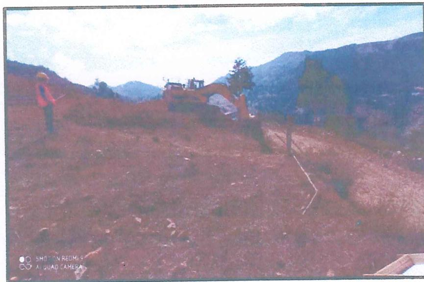
**FOTO N°02:** LIMPIEZA CON EXCAVADORA PARA LA EXTRACCION DEL MATERIAL GRANULAR PARA EL MANTENIMIENTO DEL CAMINO VECINAL EMP. PE-1NF - DV. CA-1408 (SHAMON) - CASCABAMBA - EMP. CA-1404 (TAMBILLO)" L= 15.670 km
